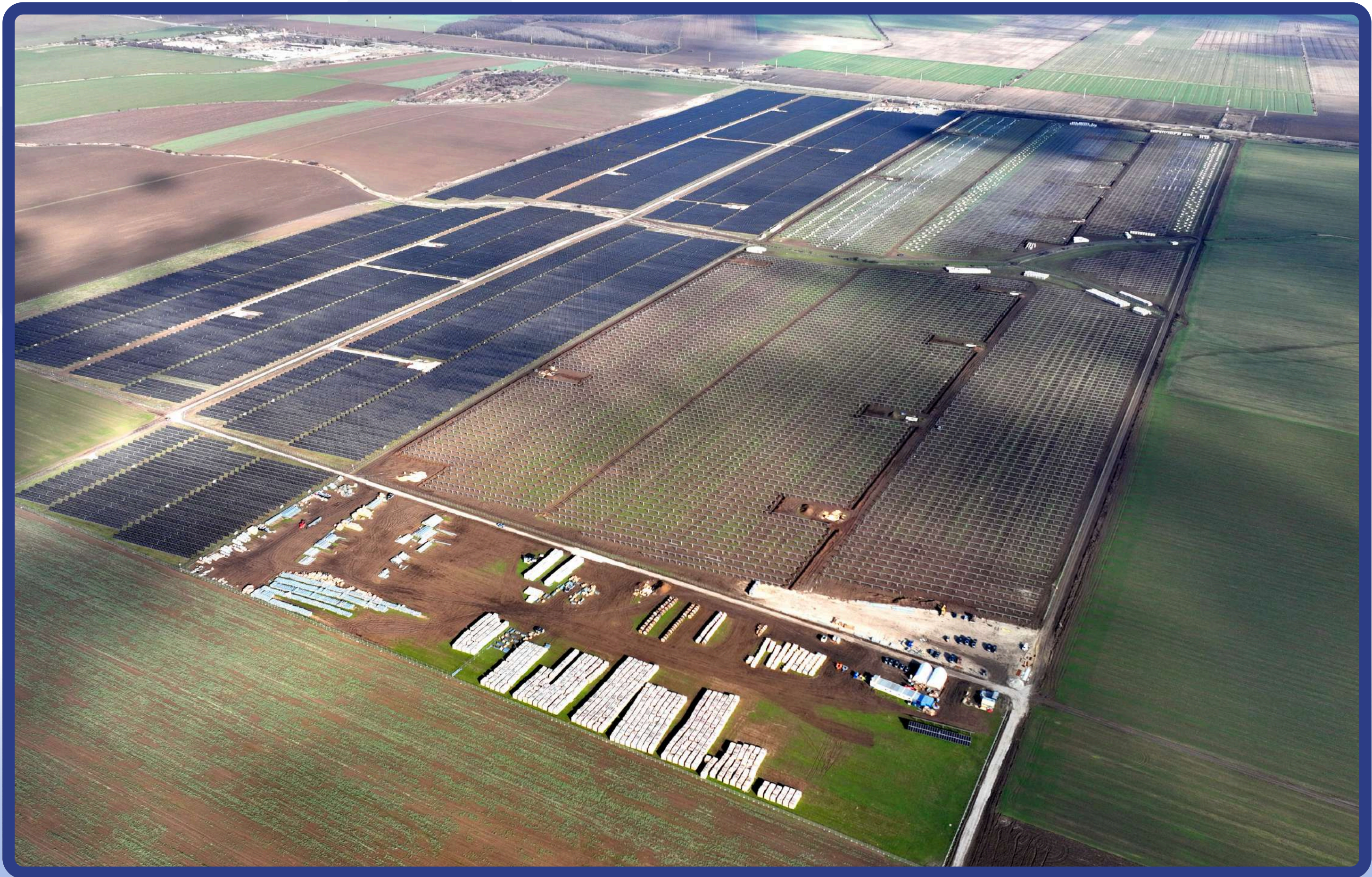
Metka EGN Mytilineos - Calugareni-Kinisi 130 MWp Soltec traker 2P - Feb 2024
